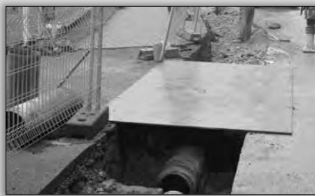
Počátkem srpna došlo po deštích v prostoru před lékárnou k propadnutí vozovky. Při následném zkoumání příčin bylo zjištěno, že celá kanalizace od malé školy až k parkovišti je na několika místech vážně narušena a velká část dešťových vod si našla cestu mimo potrubí. Tím docházelo postupně ke vzniku kaveren a následně k propadnutí vozovky. Proto se obec rozhodla opravit celý úsek desítek let starého potrubí. Oprava by měla trvat necelé tři týdny.
